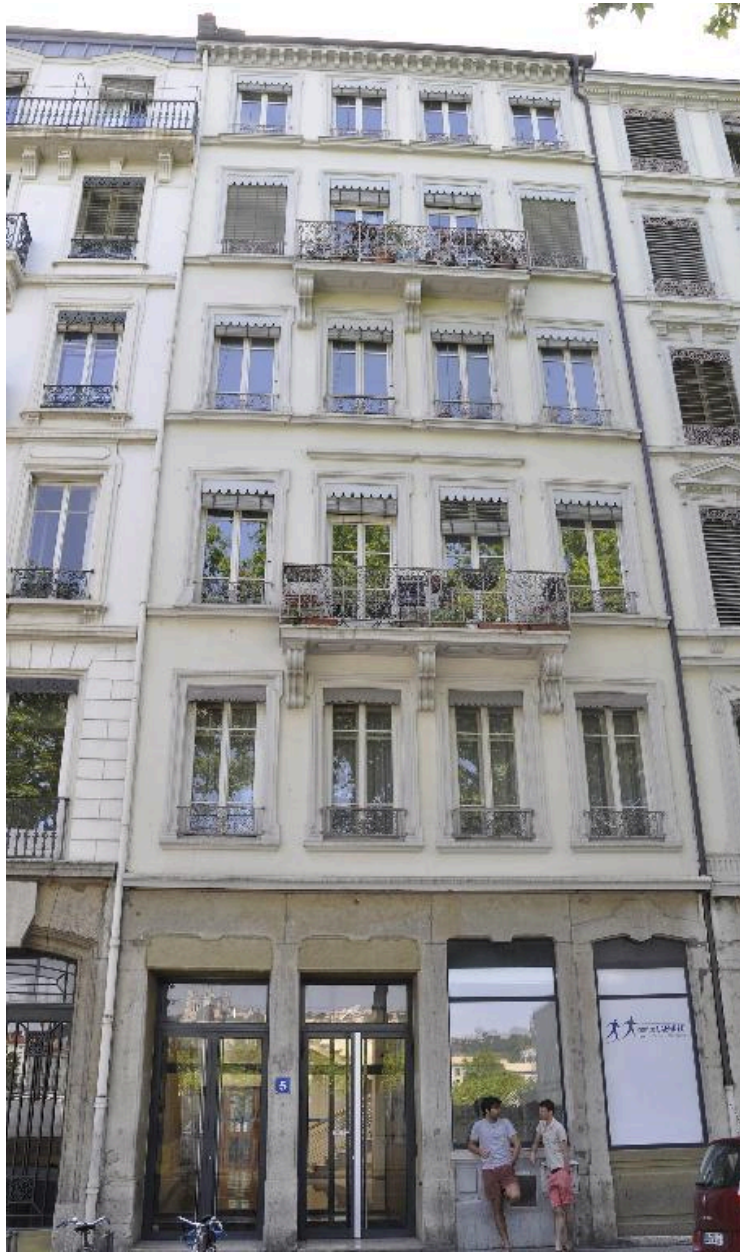
Vue générale de l'élévation sur quai
