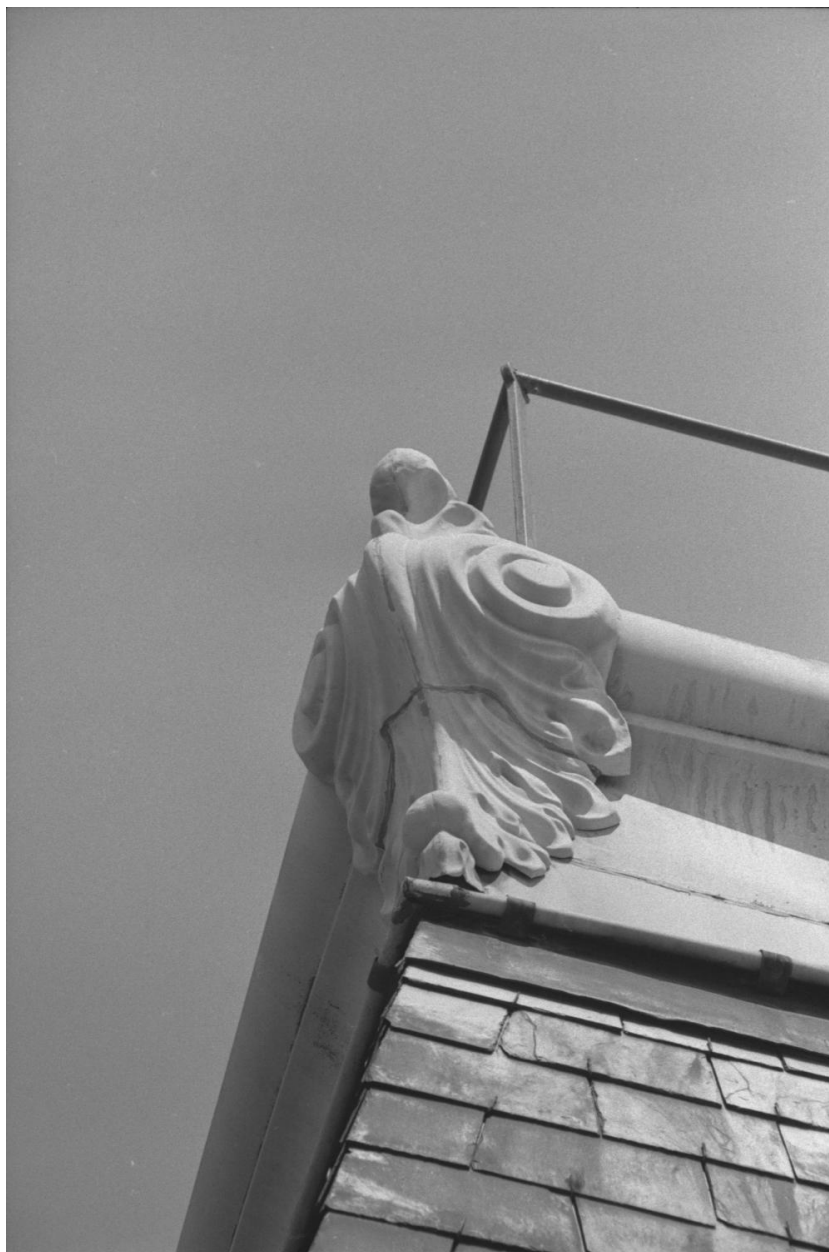
Ornement en zinc. Pavillon AB, toit, angle sud-ouest
