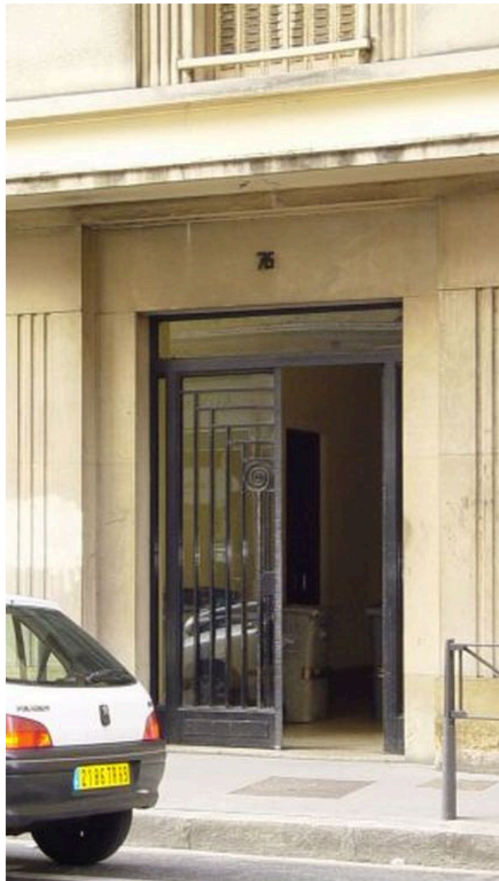
Porte d'entrée 76, rue Garibaldi
