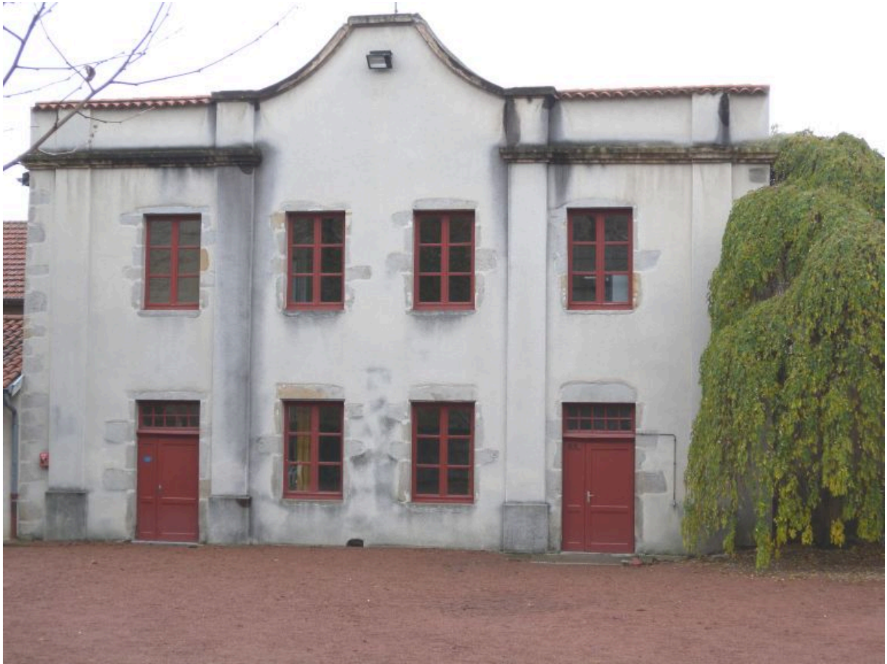
Vue générale de la maison sur jardin. Elévation principale avec couronnement pyramidé, l'amortissement a disparu.
