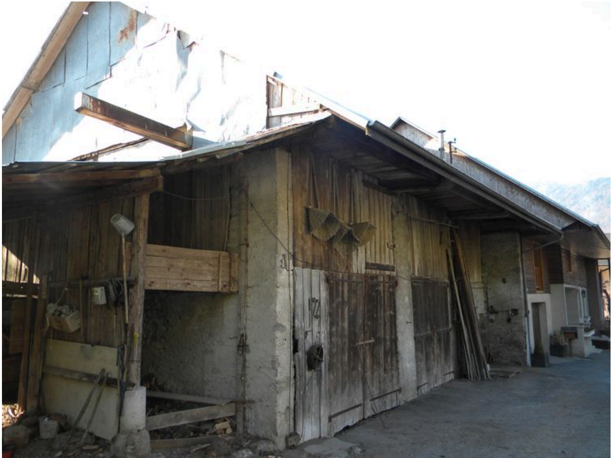
Vue de trois-quarts du bâtiment agricole.
