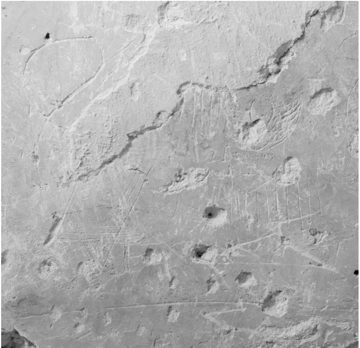
1er étage, pièce donnant sur la rue des Fontaines, enduit portant des graffiti hébraïques, détail : étoile à six branches, tête d'ange et inscription Abraham [- ]orzoi.
