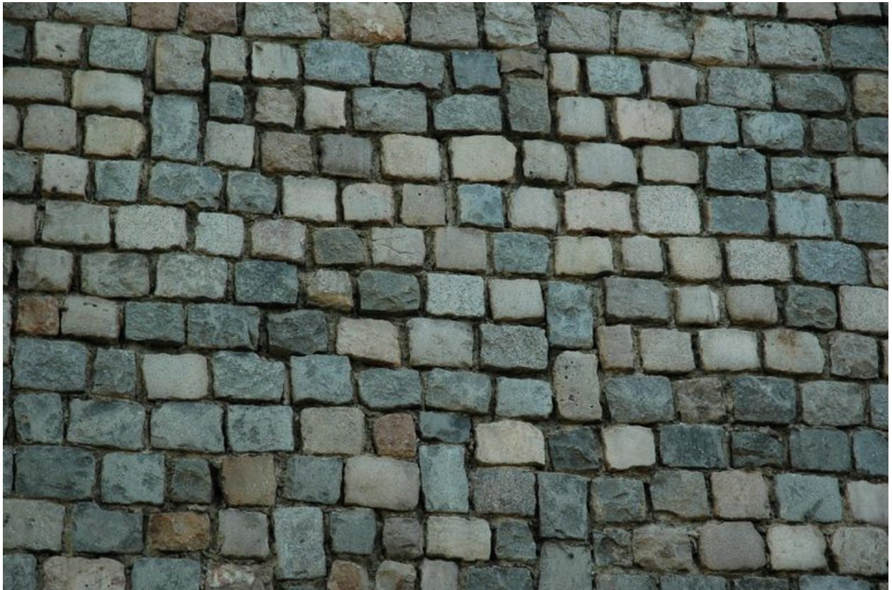
Détail du parement en moellons de la façade
