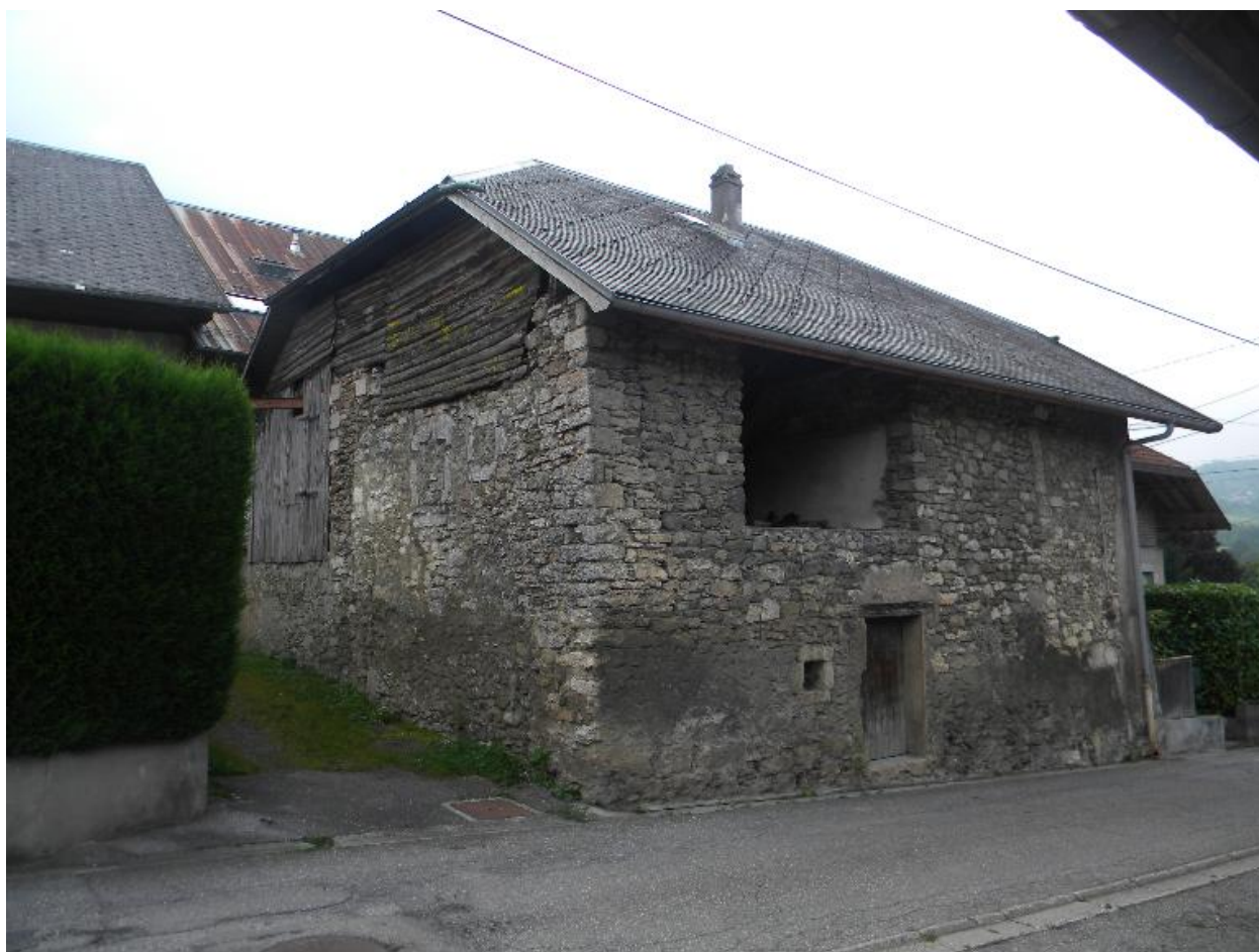
Vue de trois-quarts nord-ouest.
