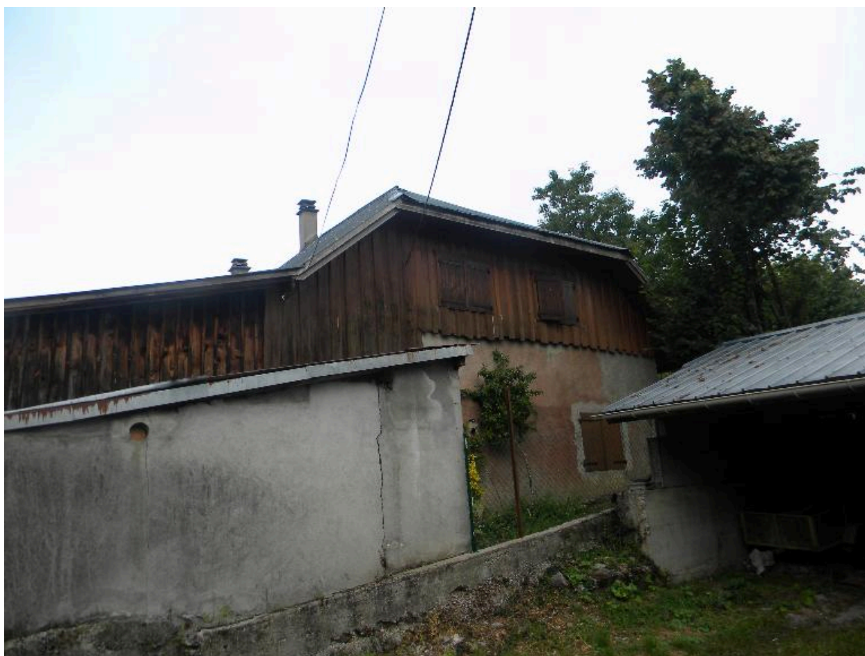
Vue du pignon est.
