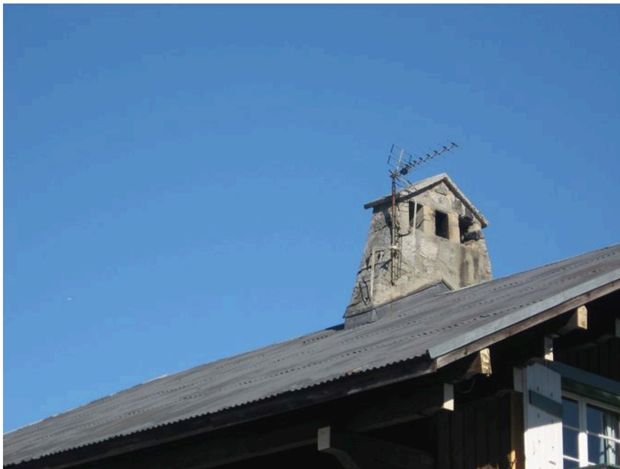
Détail de la cheminée
