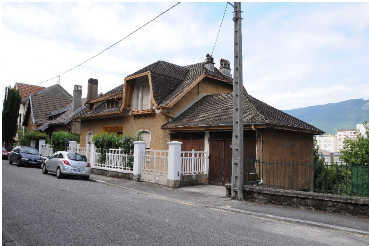
Vue générale depuis le nord
