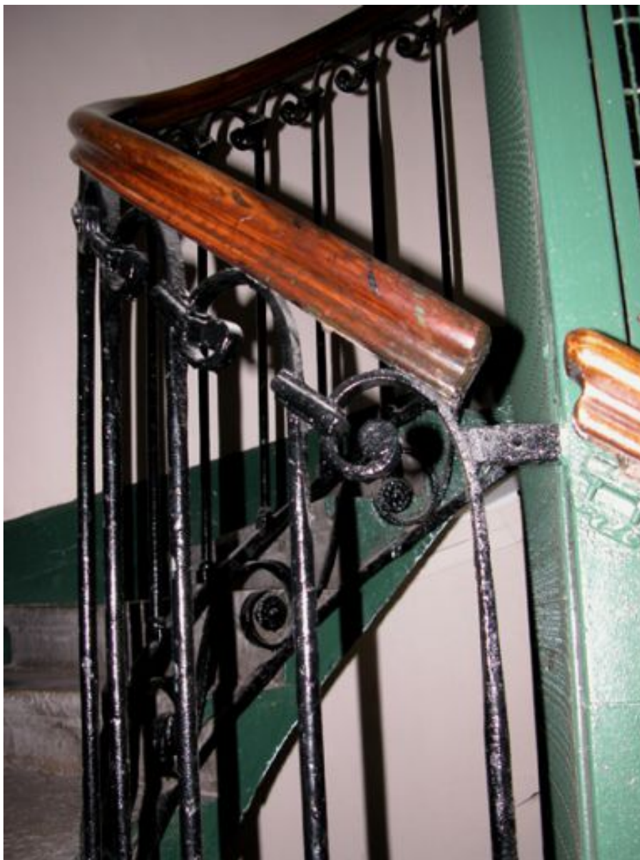
Escalier, détail de la rampe
