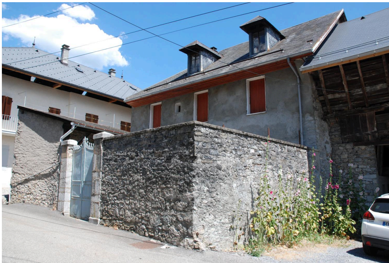
Rue de la rampe, maison à cour fermée (2018 H2 554).
