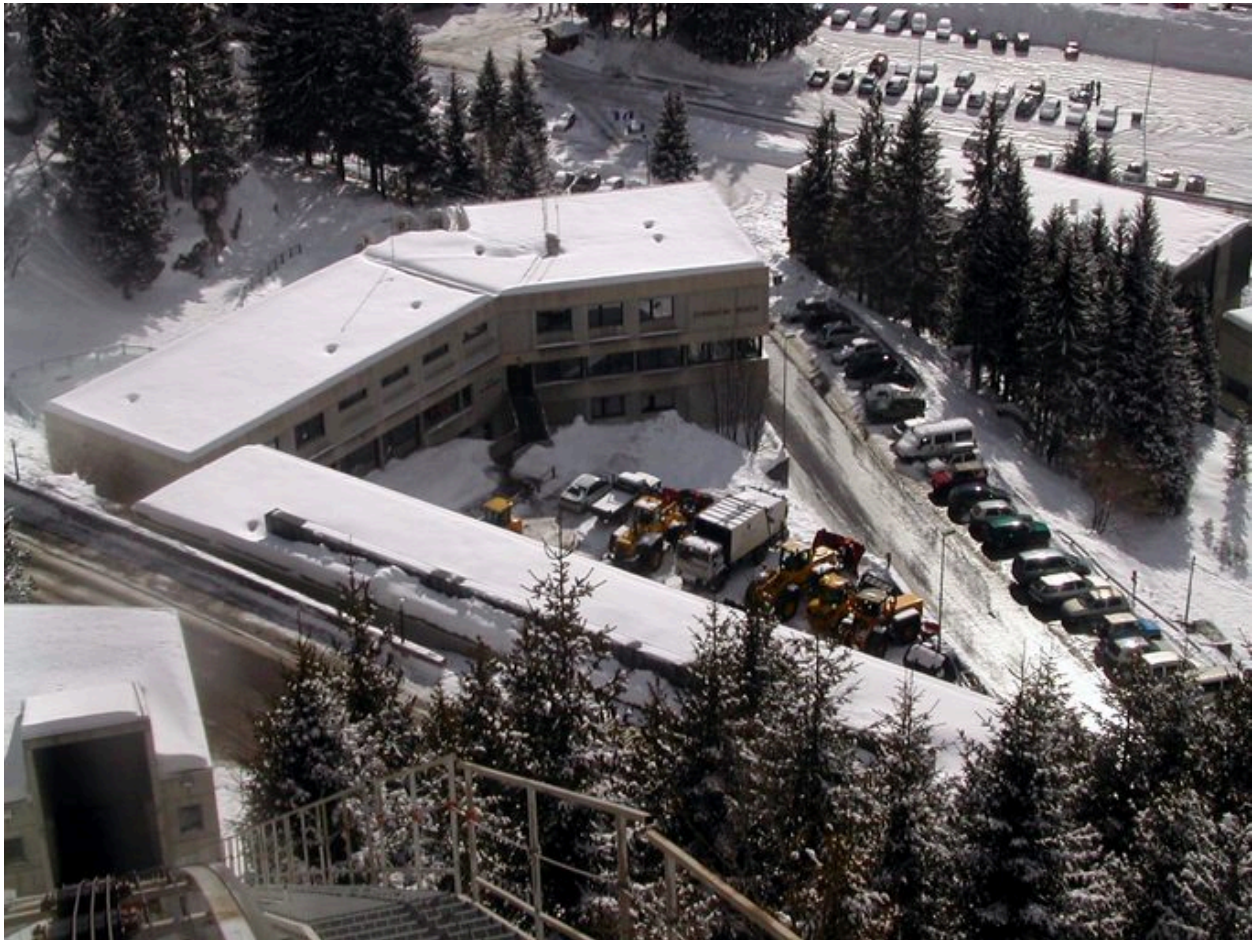
Vue d'ensemble des toitures depuis le nord
