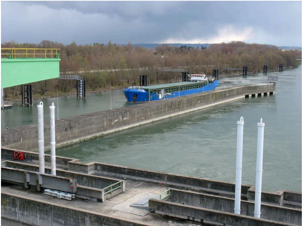
Vue partielle côté aval : mur guide aval
