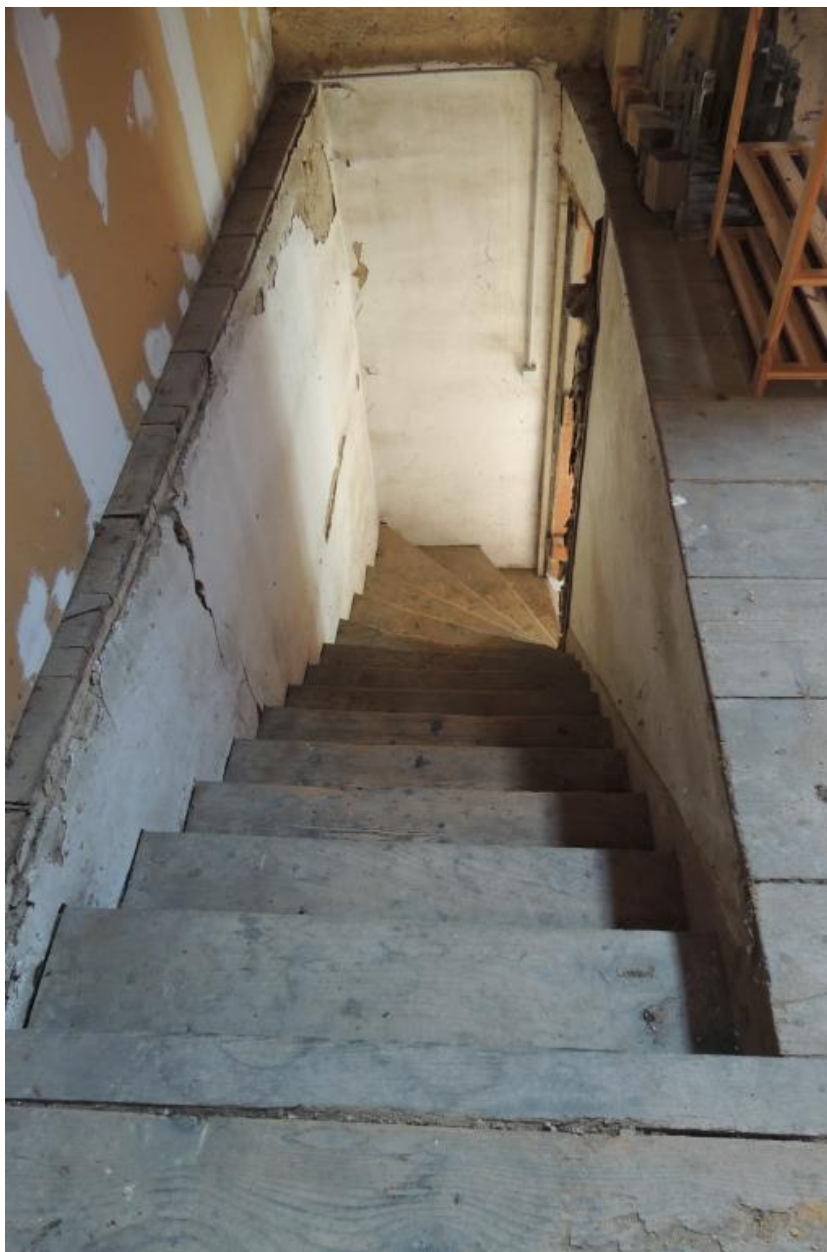
Escalier intérieur menant aux combles.
