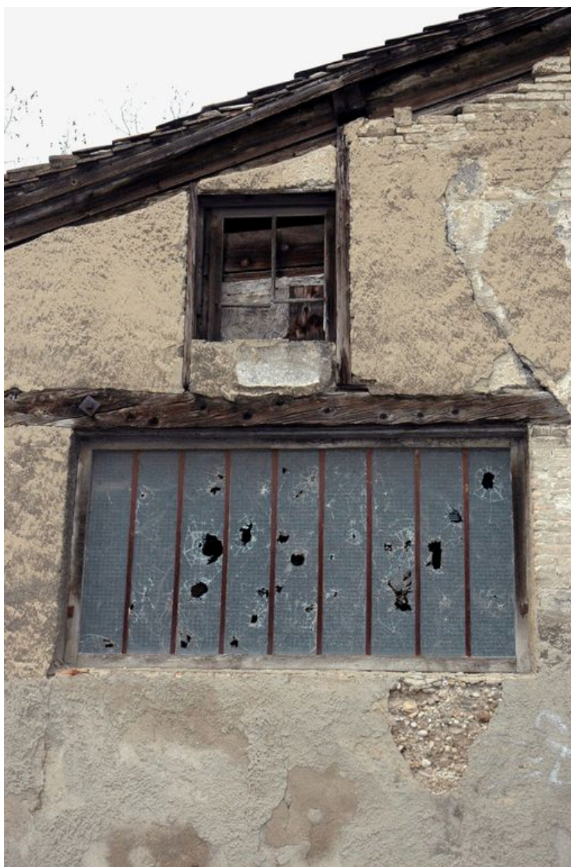
Détail de baies d'un corps de bâtiment rue de l'Eternité
