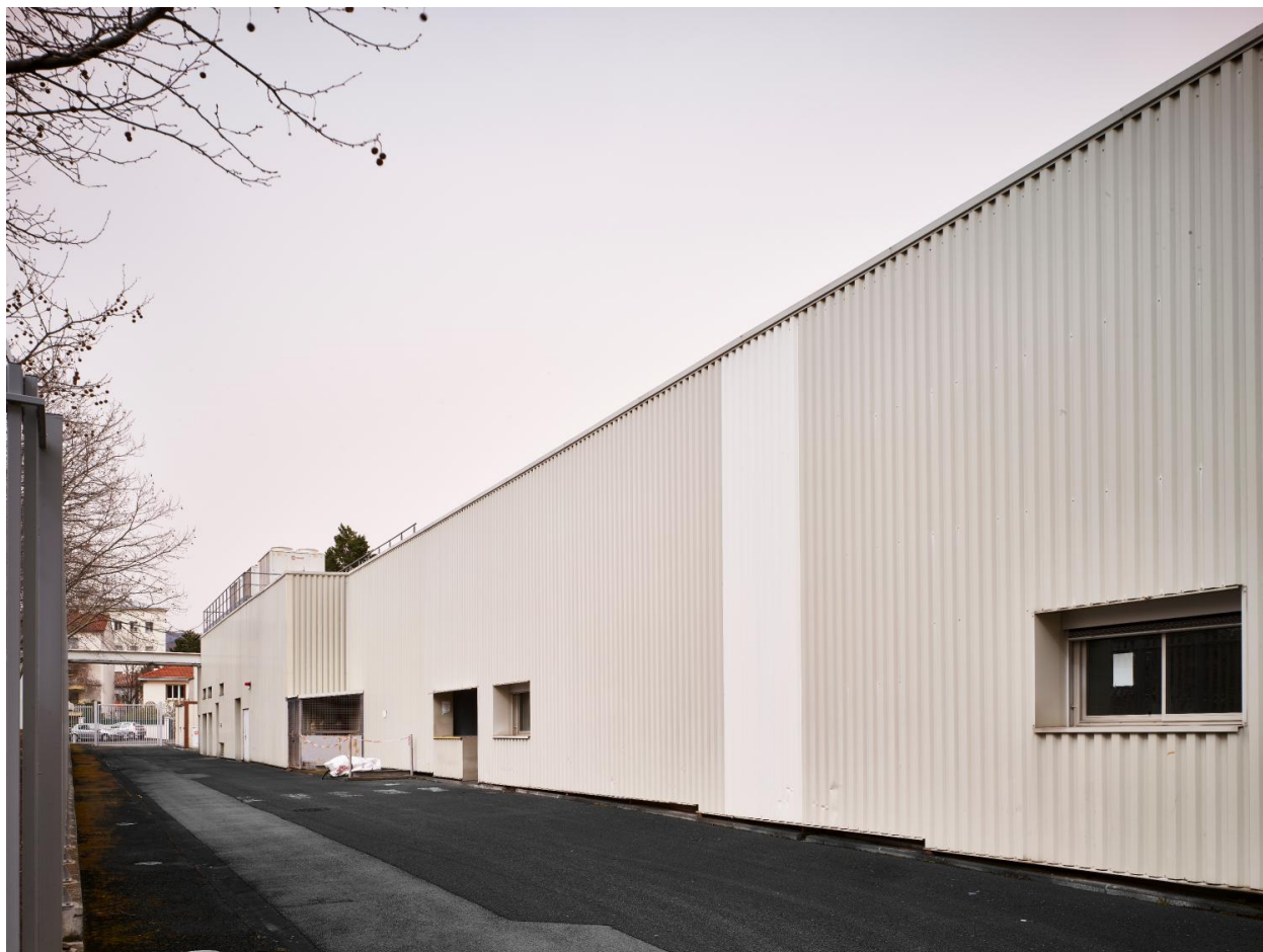
L'élévation sud des ateliers O9 (état 2022).
