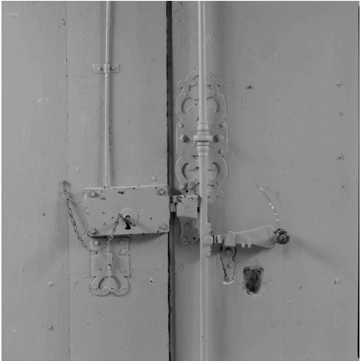
Vue intérieure : détail de la serrure.
