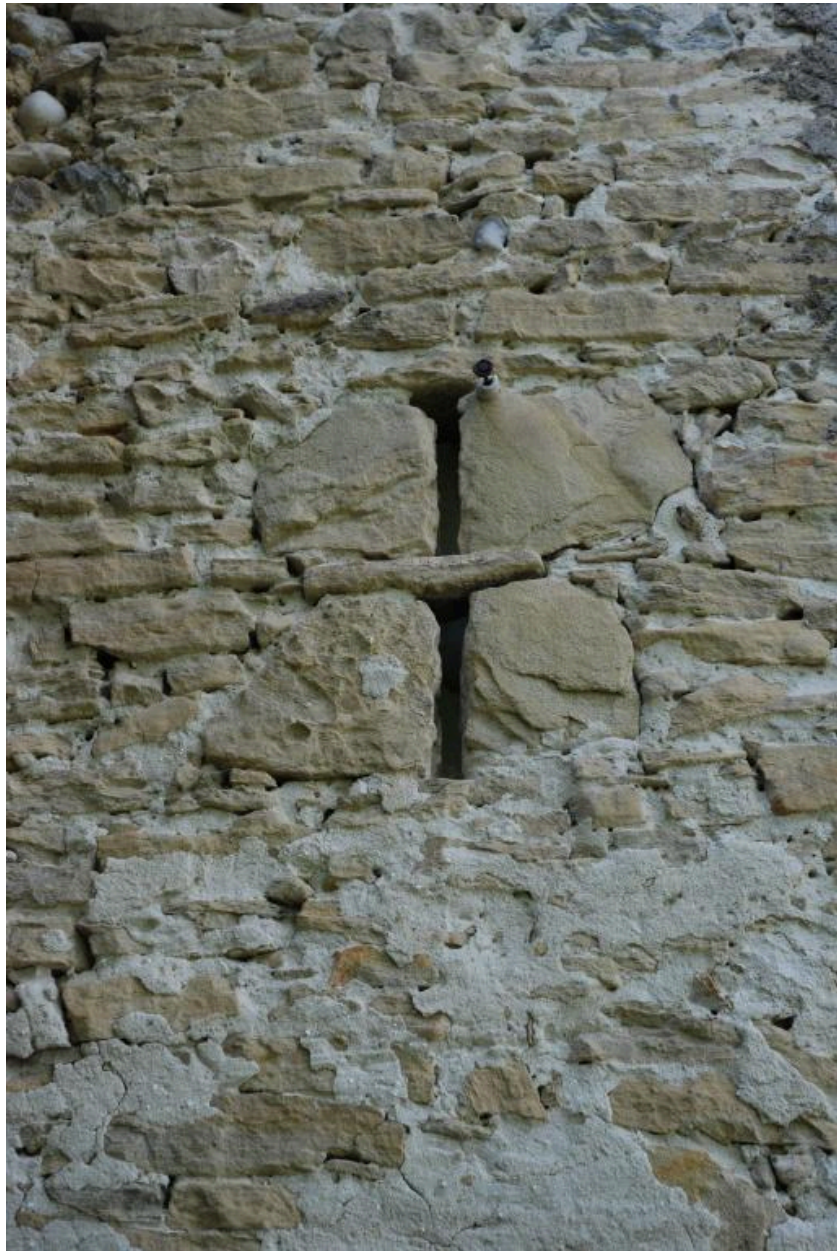
Habitation, vue arrière : détail des jours d'aération de placards.
