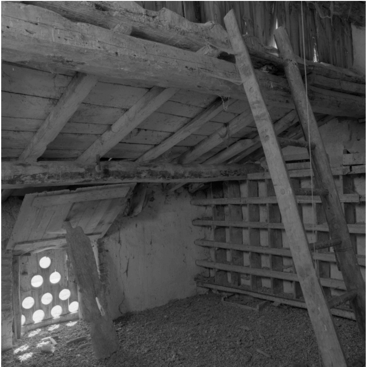
Vue intérieure du dernier niveau du colombier : nichoirs en bois.
