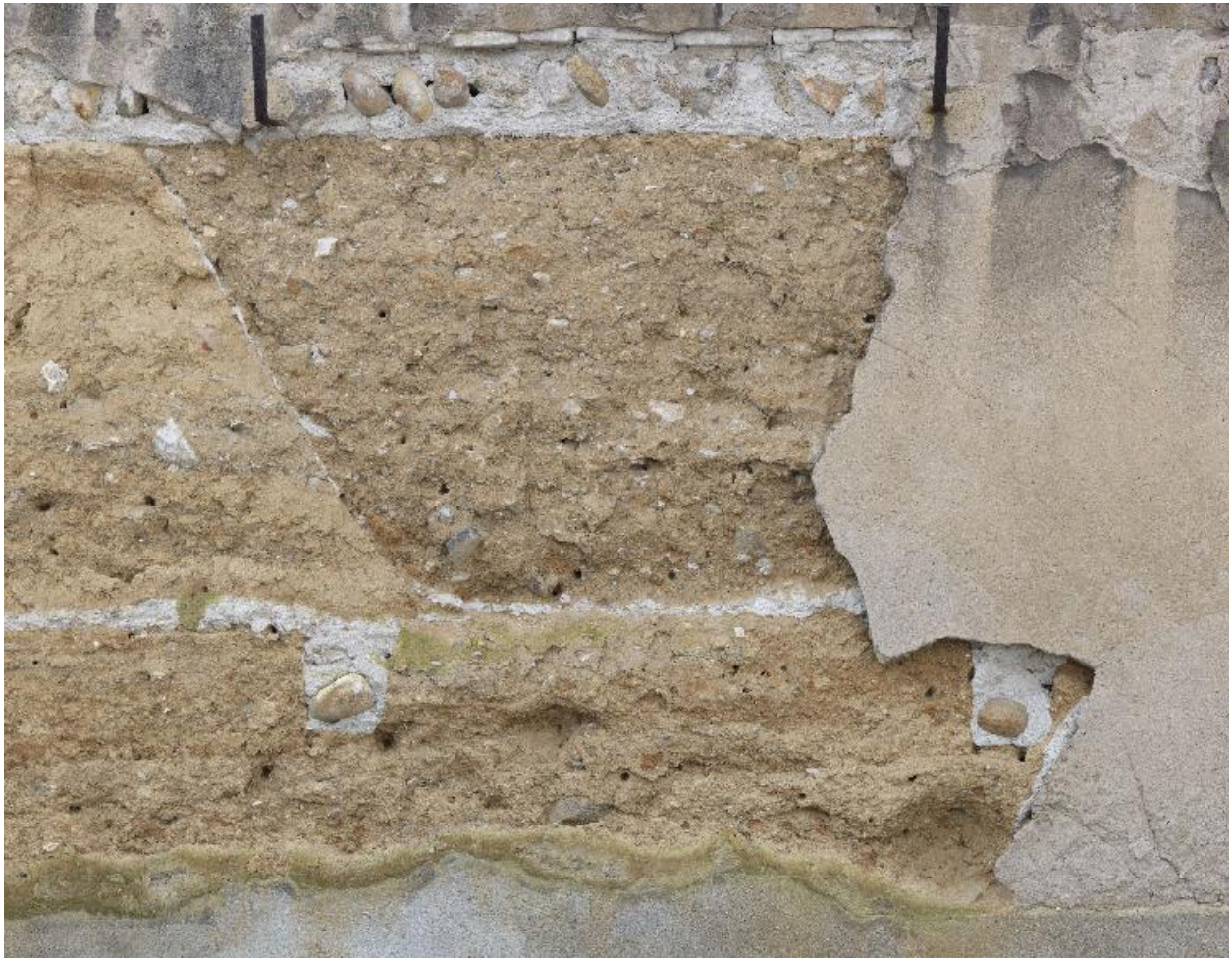
Détail du mur de clôture côté montée des Génovéfains : pisé et galets
