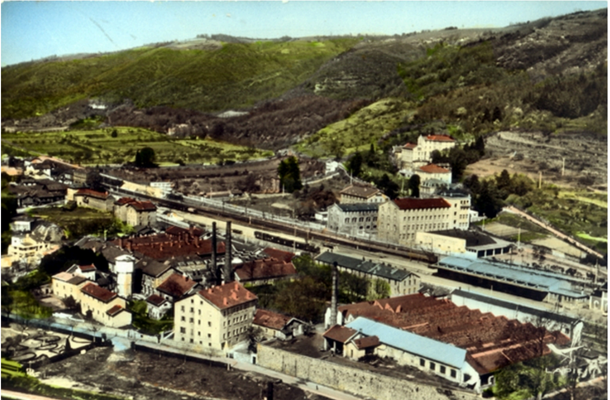
tissage et moulinerie vus du sud-ouest
