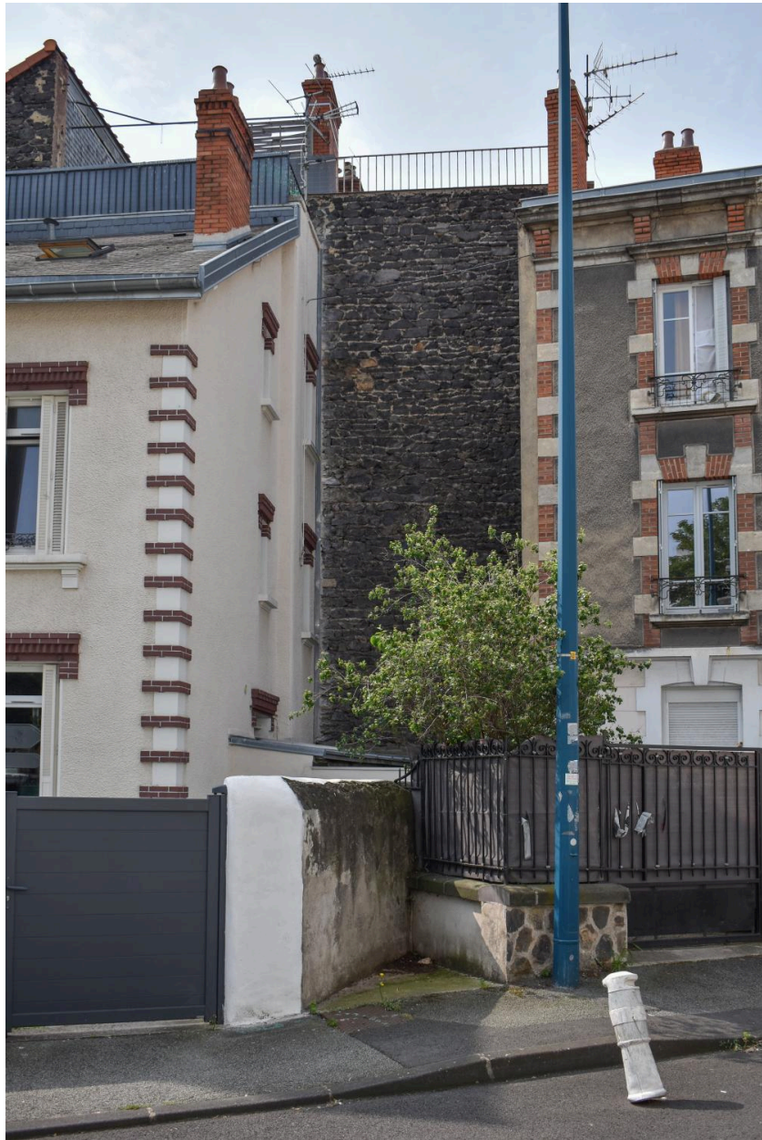
Adossement de la maison sur le mur de l'immeuble arrière
