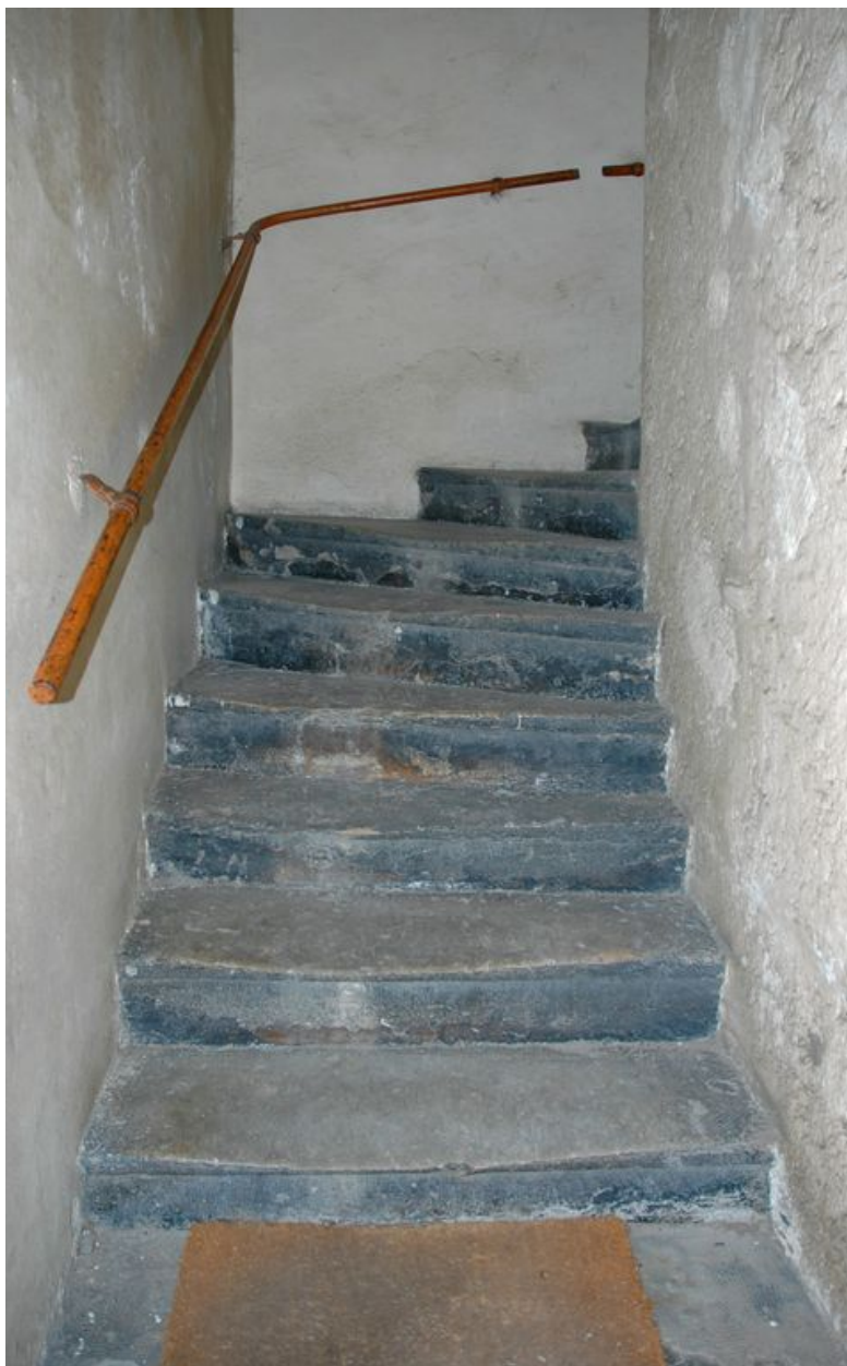
Première volée de l'escalier vue depuis le nord
