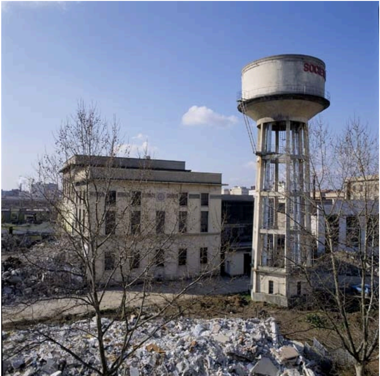
Vue d'ensemble sud avec bâtiment administratif et château d'eau
