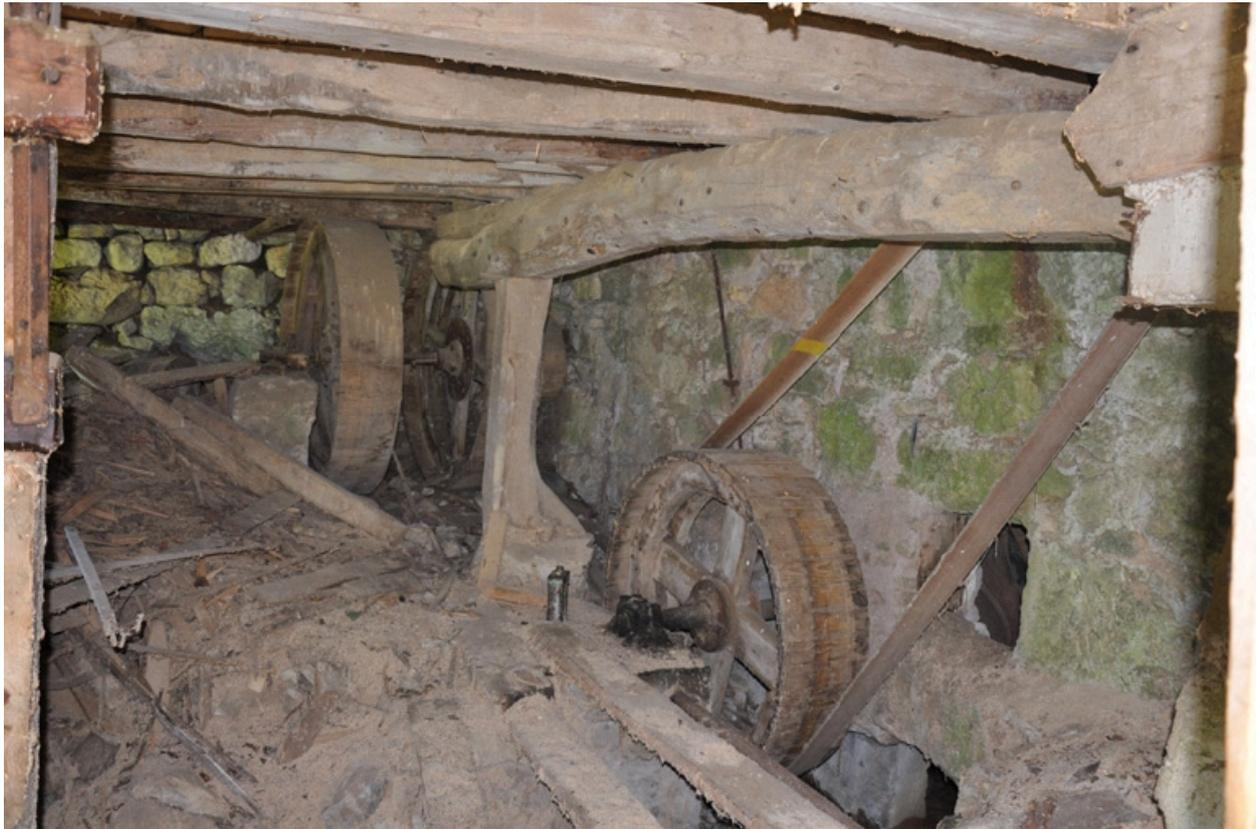
Détail de l'étage de soubassement avec les axes et courroies de transmission
