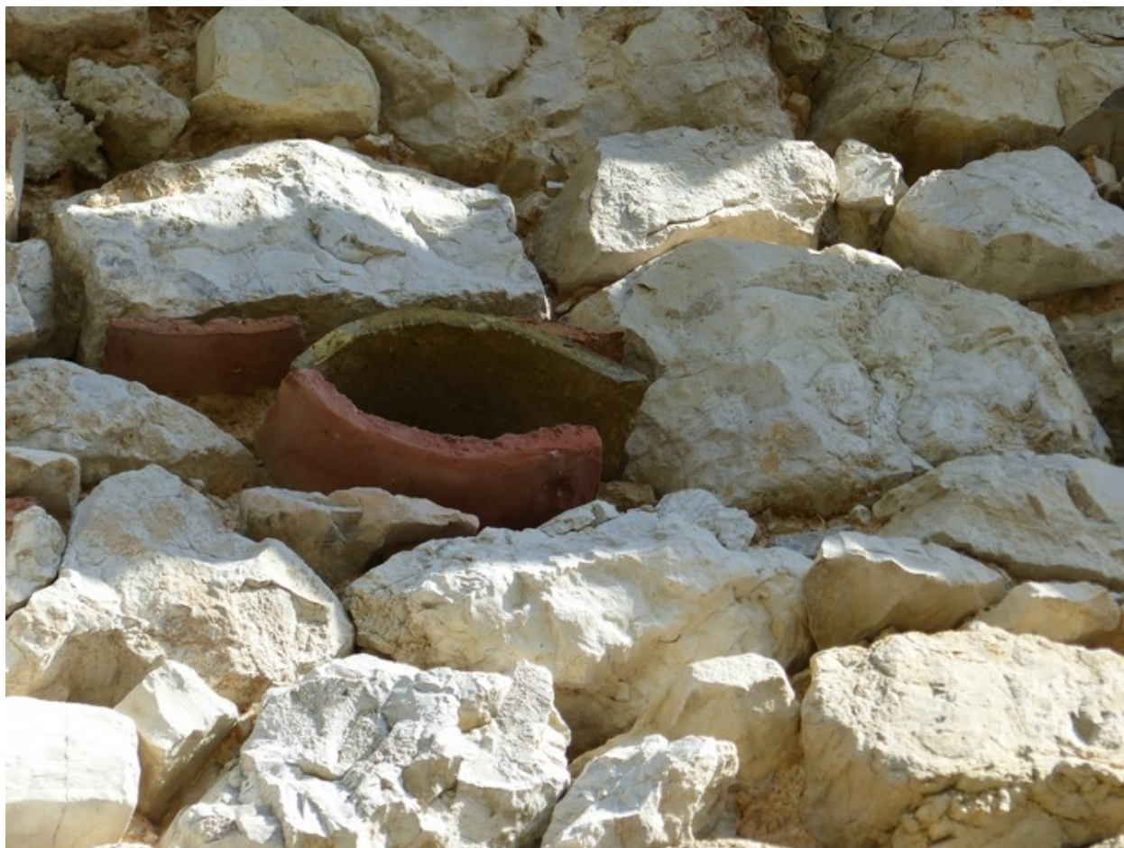
Aération de fenil en tuile creuse, sur une maison au Terron.
