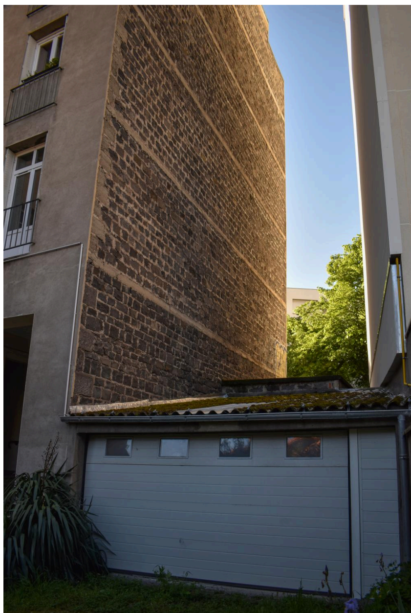
Elévation aveugle latérale de l'immeuble
