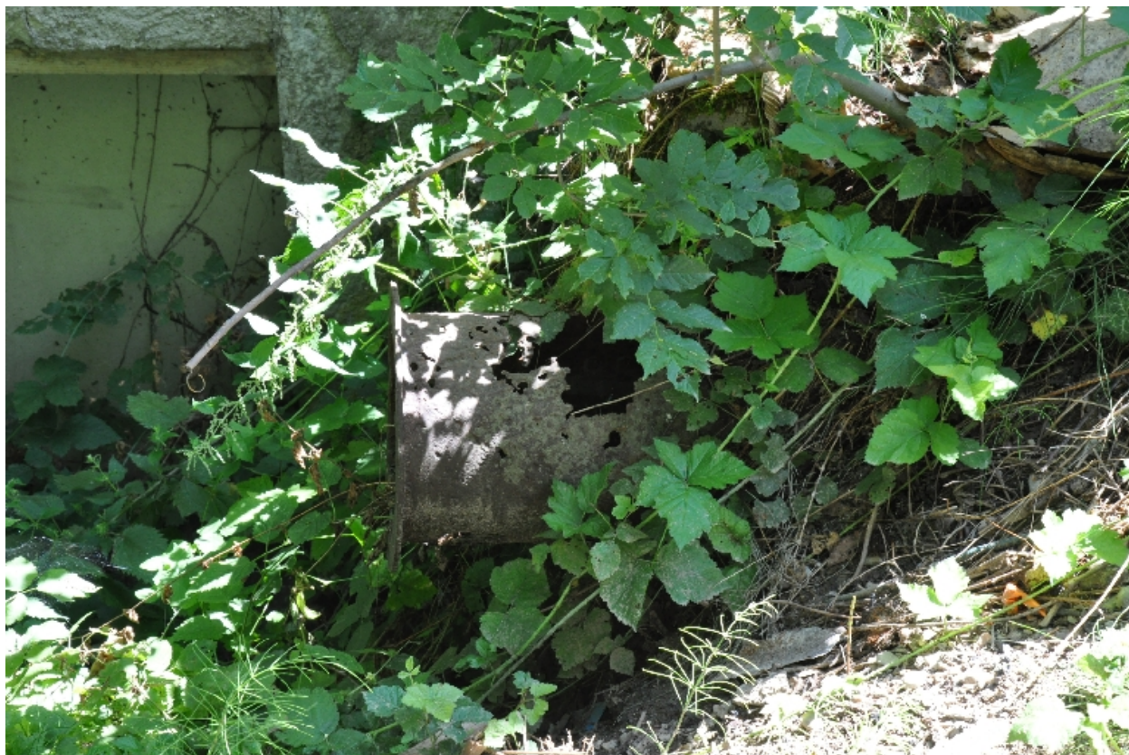
Vue de l'ancienne conduite forcée
