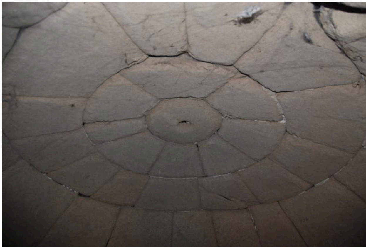
Détail de la voûte du four.
