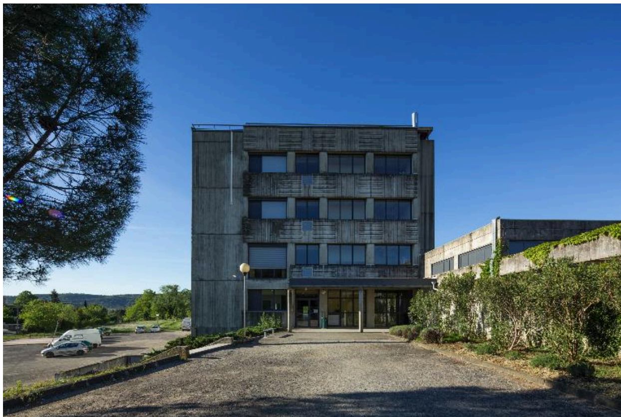
Bâtiment sud : pignon nord
