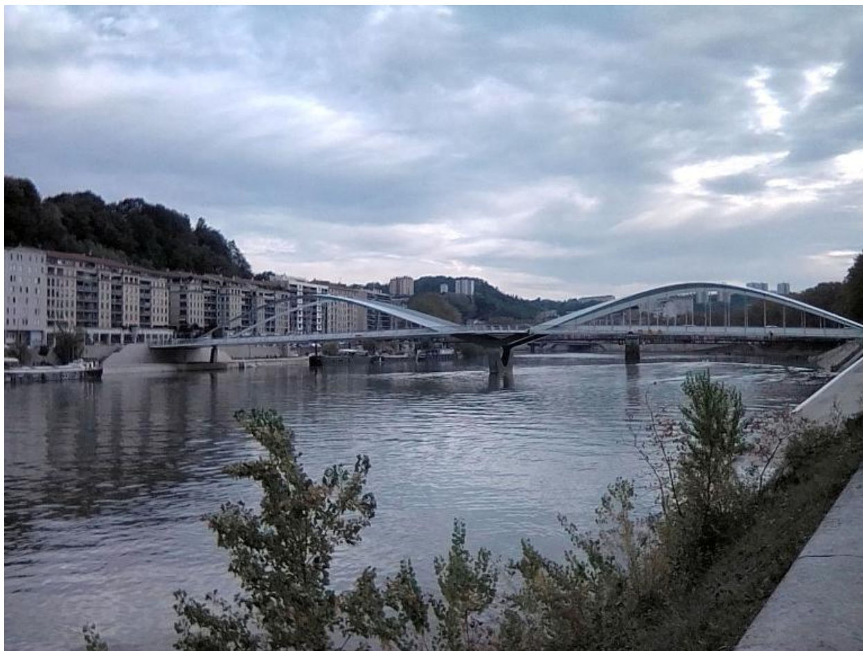
Vue d'ensemble nord du pont Schuman
