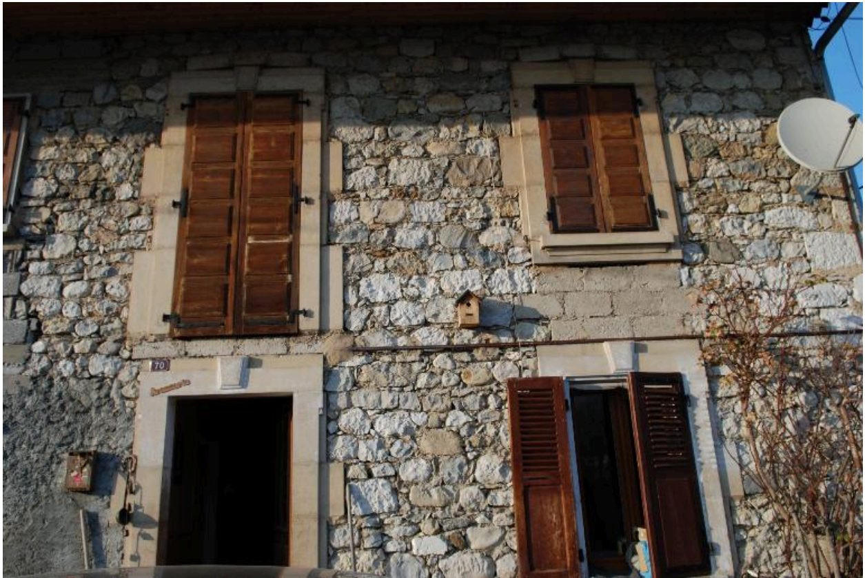
A3 282, Balevaz, maison. Détail de la façade principale aux ouvertures en ciment moulé
