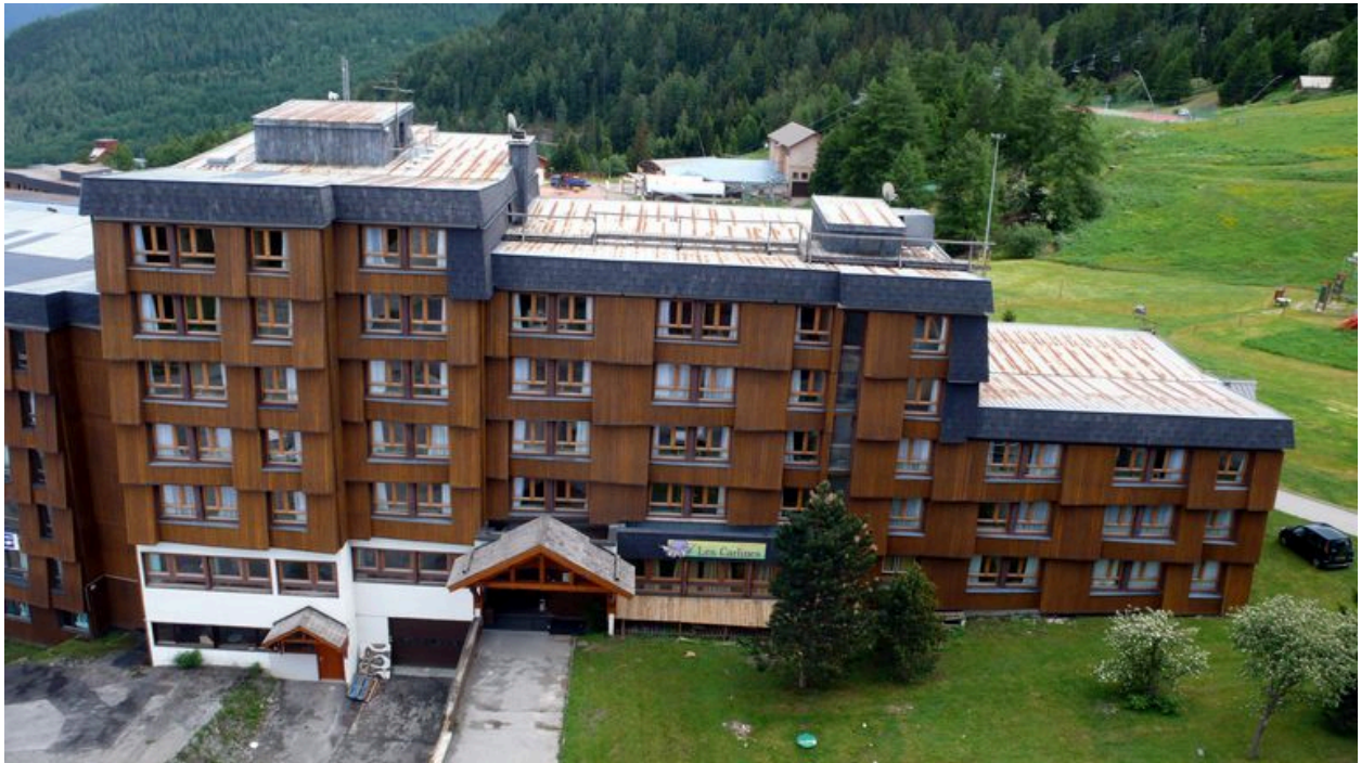
Vue plongeante depuis le nord-ouest
