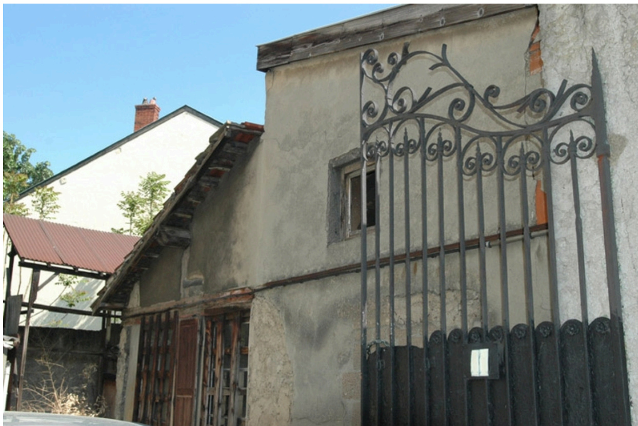
Portail d'entrée et atelier sur cour, vue sud ouest.
