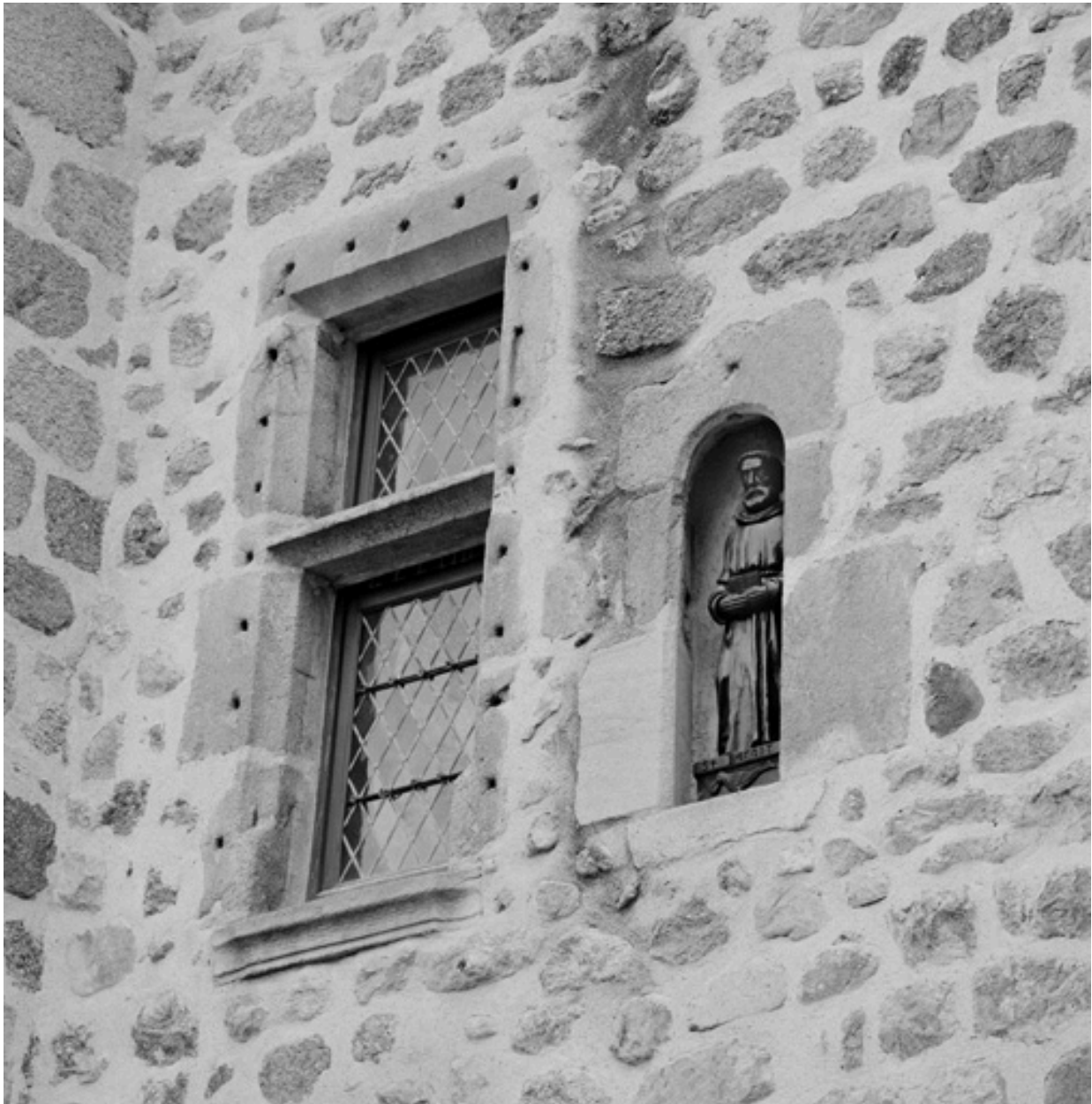
Façade nord : détail des fenêtres situées au-dessus de l'entrée du cloître.
