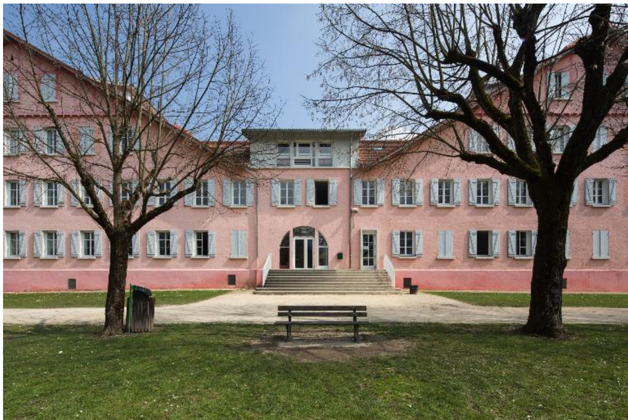
Bât. A : façade ouest de l'aile ouest
