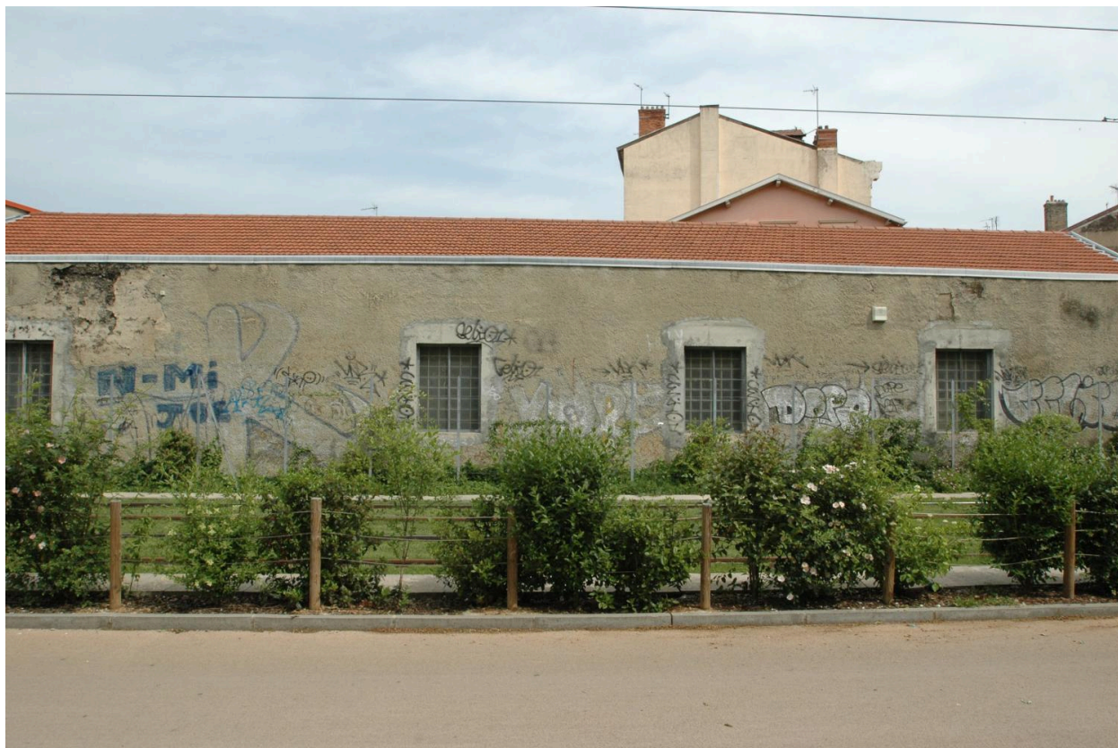
Détail façade sur la voie ferrée de l'Est
