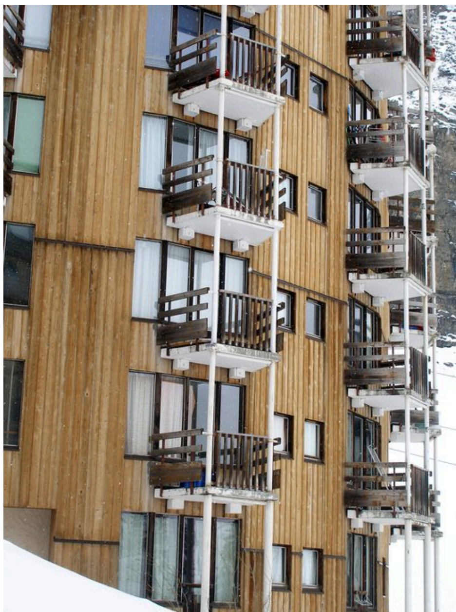
Détail des balcons de la façade sud
