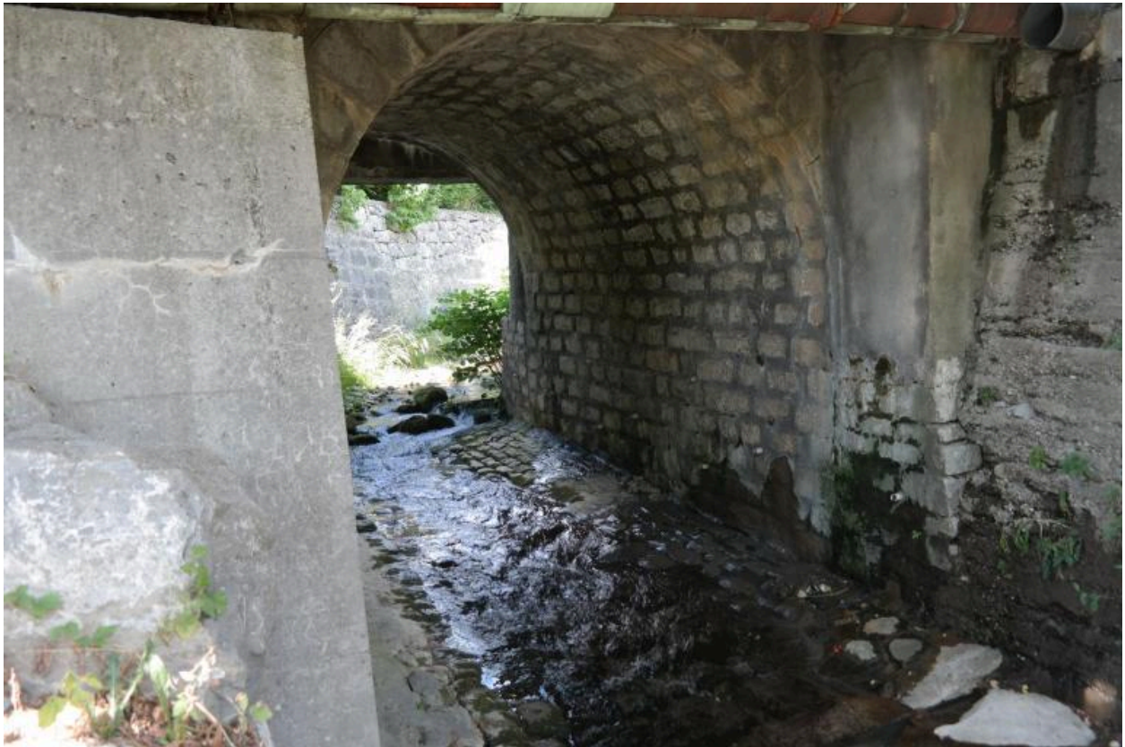
Pont du Nant de la Ville, détail de la voûte et du lit du ruisseau
