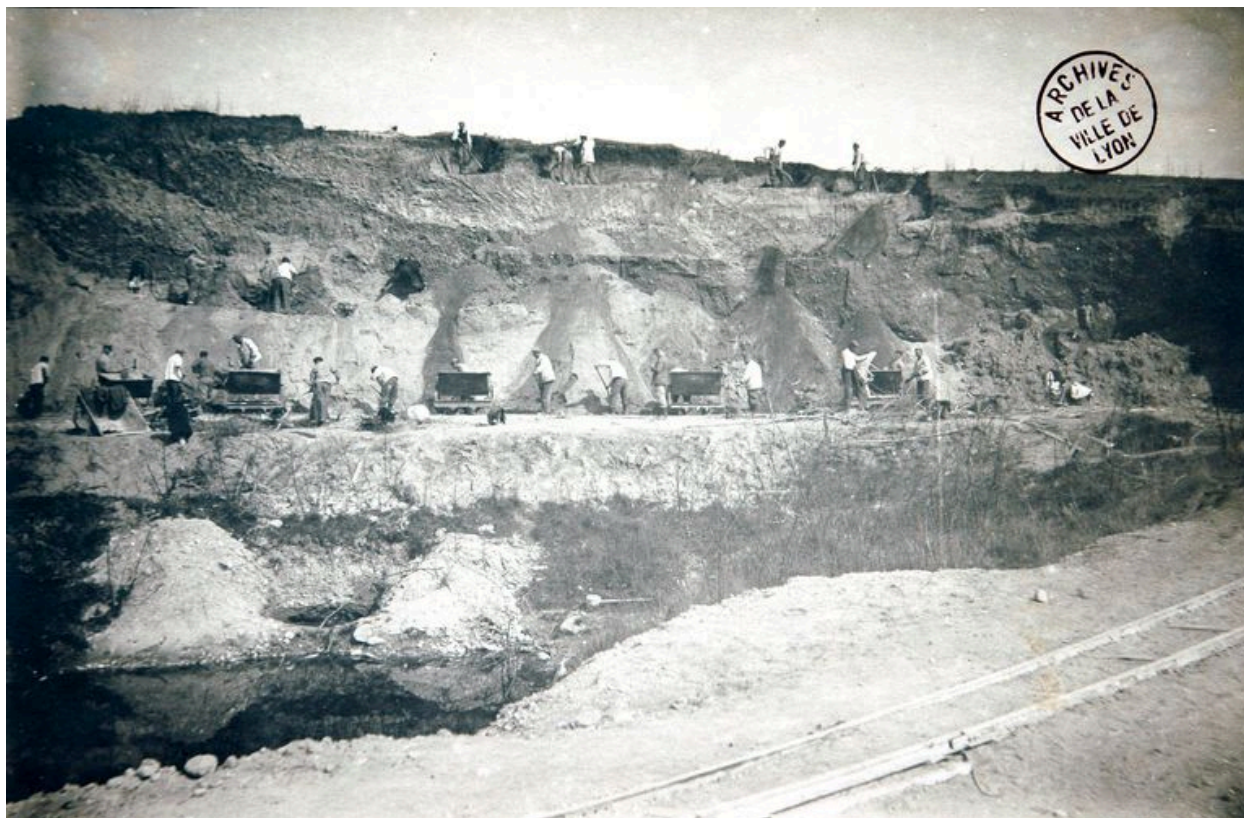
Le nivellement du terrain. Photogr., vers 1916 (Arch. mun. Lyon. 959 WP 140)
