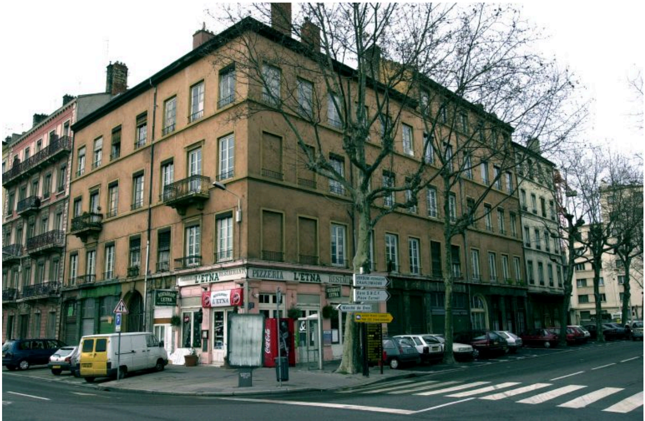
Vue d'ensemble depuis le nord-est, angle du quai Perrache et du cours Suchet
