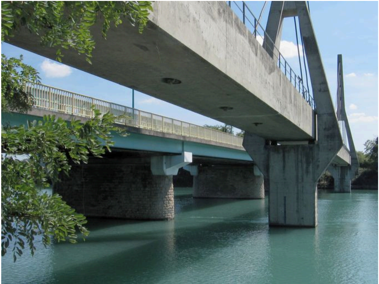
Tablier vu de dessous (depuis la rive droite)
