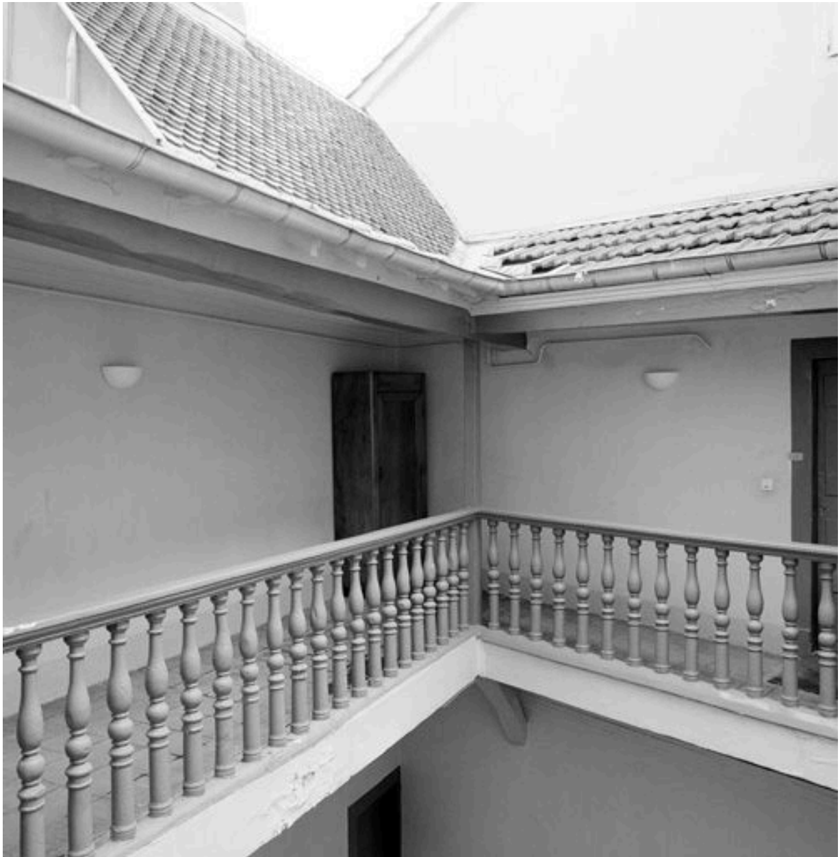
Coursière en bois du dernier étage, vue depuis l'escalier
