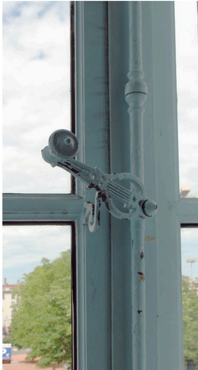
1er étage, pièce donnant sur rue, détail de la poignée de l'espagnolette
