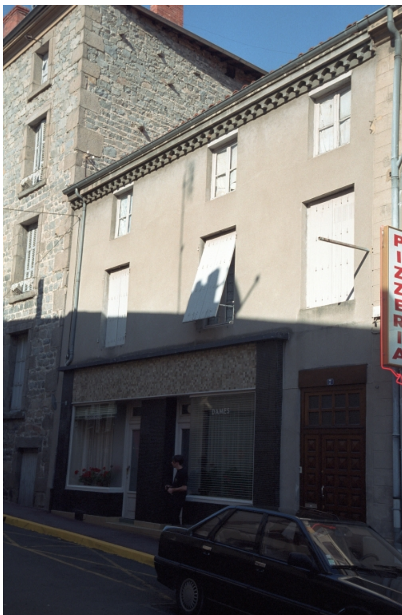
Boën, îlot 18, Saint-Jean (rue) 7. Vue générale de la façade sur rue.
