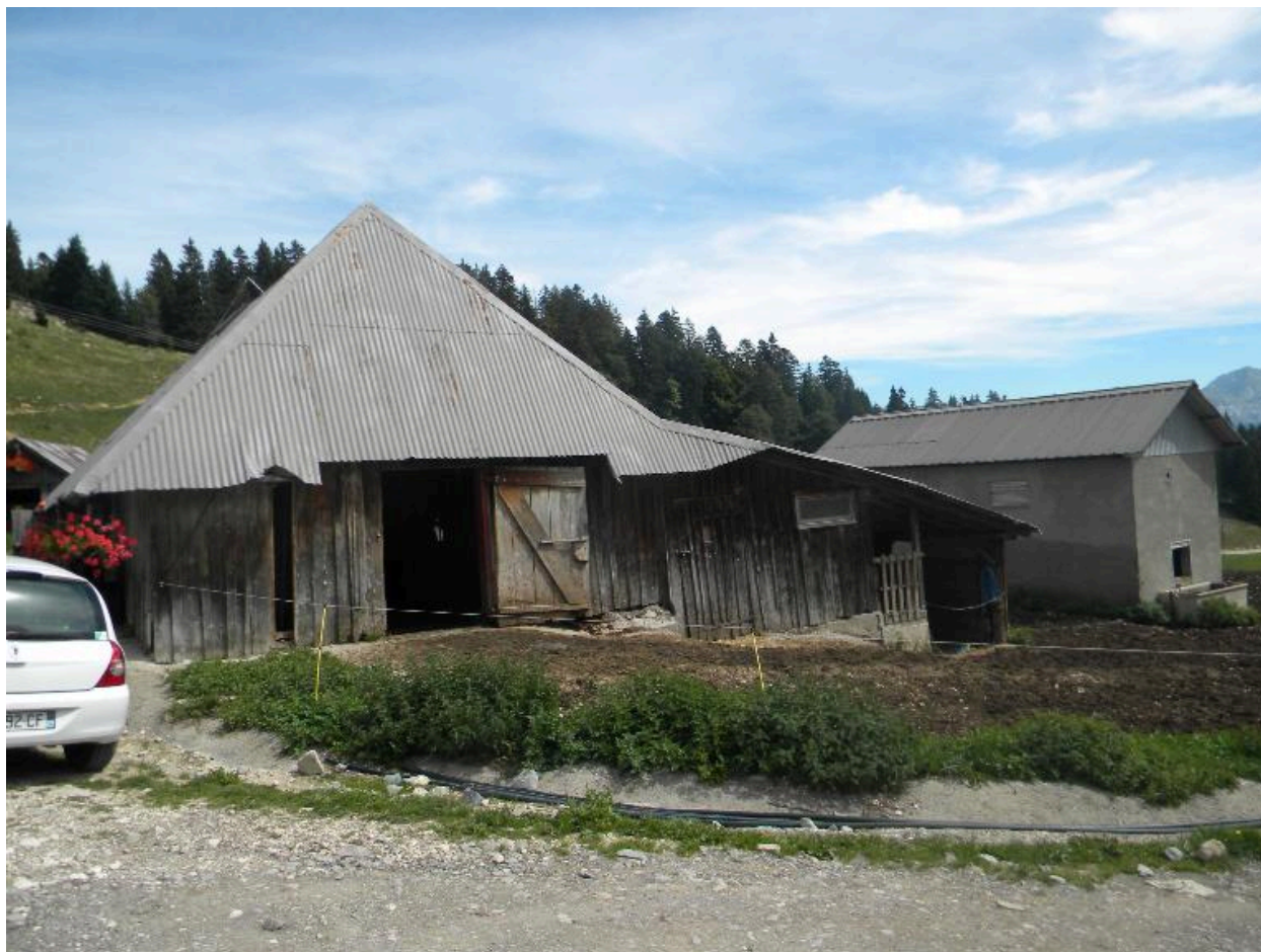
Vue du pignon ouest de l'étable.
