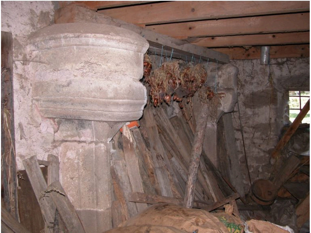
Corps de bâtiment encadrant au sud le portail d'entrée, vue d'ensemble de la cheminée du rez-de-chaussée.
