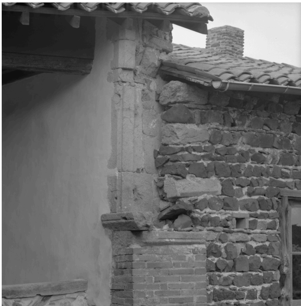
Cour intérieure, pierres en remploi dans le mur entre le passage couvert et le fournil.
